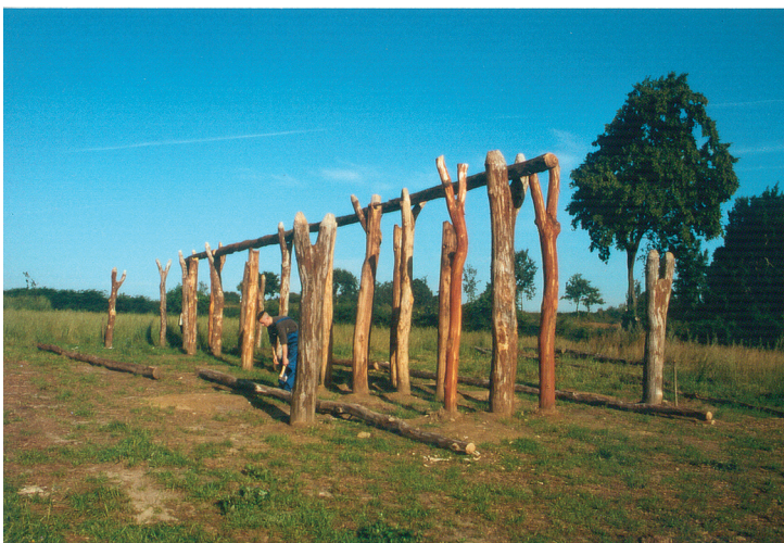
Abb. 3. Zuerst werden die tragenden Strukturen der Hausmodelle errichtet (hier beim Typ Pennigbüttel). Foto AÖZA, Albersdorf.
